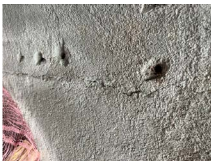
Sprekkdannelse på yttermur
