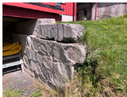
Forvitring og deformasjon av mur
