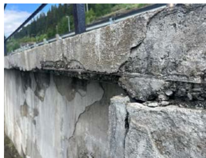
Forvitring og deformasjon av mur
