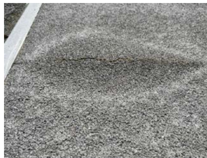
Utetthet tettesjikt over garasje
