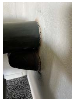
Brennbart material er inntil skorstein
