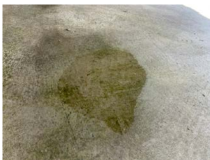
Fukt/vannspeil på gulv under befaring
