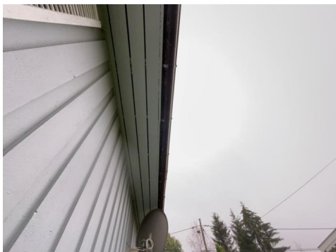
Luftespalte i gesims.
