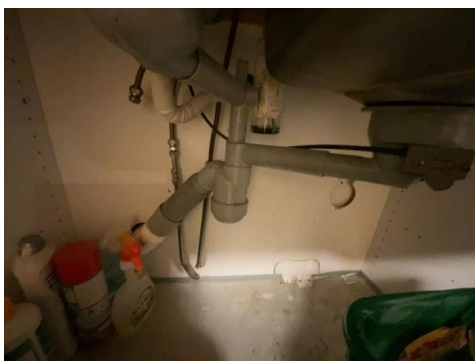
Synlige rør under kjøkkenbenken i kjelleren.
