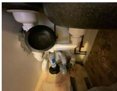
Synlige rør under kjøkkenbenken i 1. etasje.
