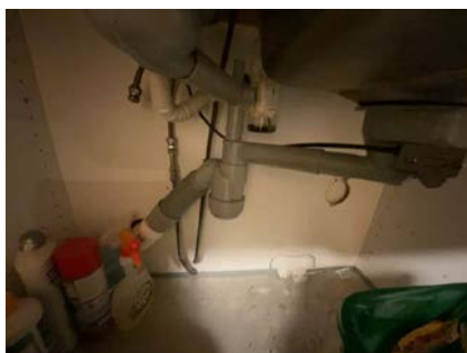
Synlige rør under kjøkkenbenken i kjelleren.
