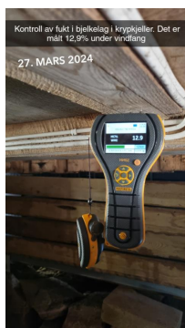
Kontroll av bjelkelag i krypkjeller. Måling under vindfang viser 12,9 % og ingen forhøyde fuktavvik
