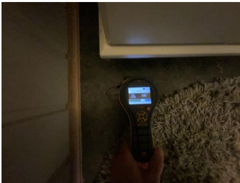
Fuktsøk er utført ved innredning uten å finne forhøyde fuktavvik
