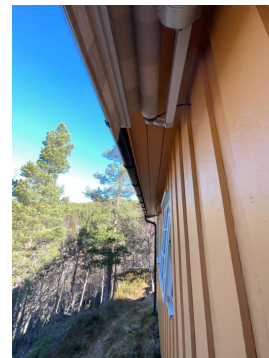
Små luftespalter i raftekasse i front på hytta
