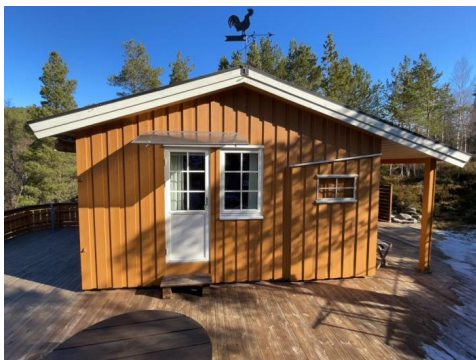
Oversikt vegg og levegg.
