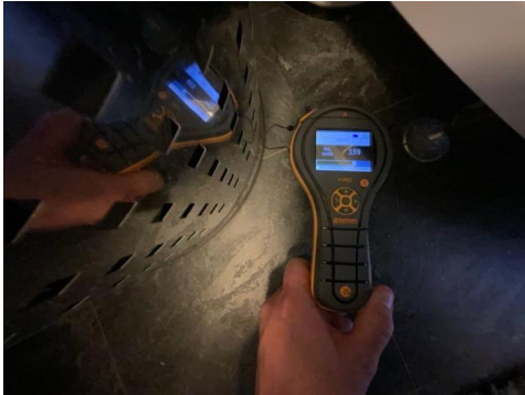
Fuktsøk er utført ved dusjkabinett uten å finne forhøyde fuktavvik
