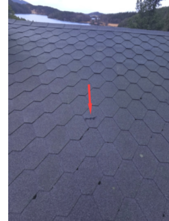
Eldre rep av tak. Ingen skade å se
