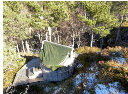
Badestamp har midlertidig tak over med presenning. Bilde er hentet fra rapport utført i 2024
