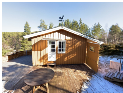
Levegg er utsvingbar og kan flyttes for montering på hjørne i front. Bilde er hentet fra rapport utført i 2024
