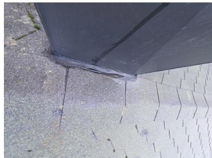
Står noe vann på oversiden av pipehatten. Ingen synlige skader
