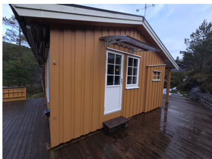
Oversikt vegg og levegg
