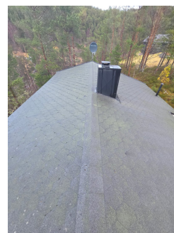
Oversikt mot pipehatt og lufterør
