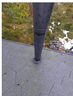
Lufterør til muldo er ikke fjernet ved montering av Jets toalett. Kan fjernes om det er ønskelig ifb. bytte av takteking
