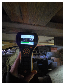
Kontroll av bjelkelag i krypkjeller. Måling viser 16,0 % og ingen forhøyde fuktavvik
