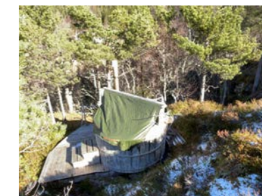
Badestamp har midlertidig tak over med presenning. Bilde er hentet fra rapport utført i 2024
