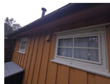
Små luftespalter i raftekasser
