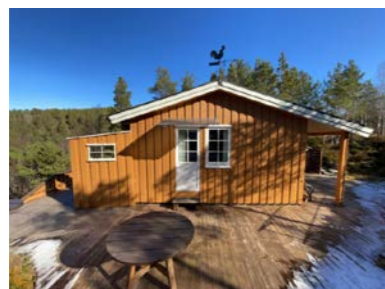
Levegg er flyttbar, her er den montert på fremre hjørne. Bilde er hentet fra rapport utført i 2024.
