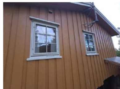
Vindu på soverom
