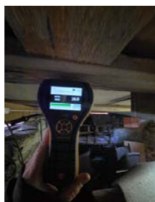
Kontroll av bjelkelag i krypkjeller. Måling viser 16,0 % og ingen forhøyde fuktavvik
