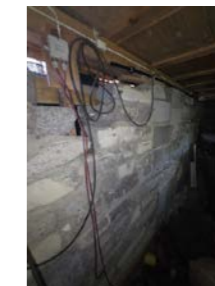
Støttemur under under hytten
