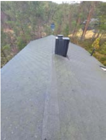
Oversikt mot pipehatt og luftør
