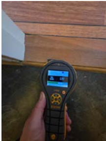
Fuktsøk er utført på gulv ved dør uten å finne forhøyde fuktavvik
