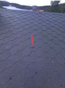
Eldre rep av tak. Ingen skade å se
