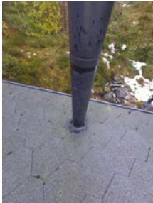
Lufterør til muldo er ikke fjernet ved montering av Jets toalett. Kan fjernes om det er ønskelig ifb. bytte av taktekking
