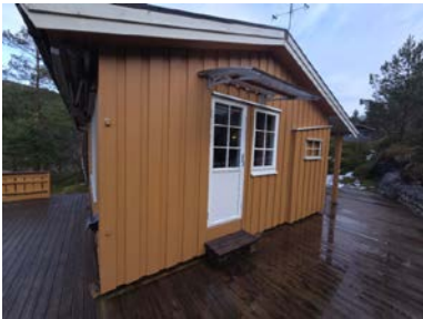
Oversikt vegg og levegg
