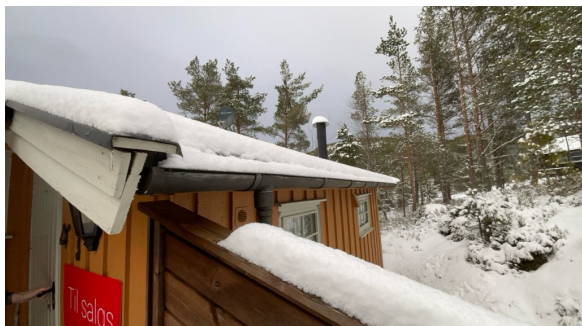
PVC takrenner på oversiden
