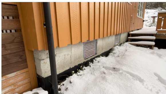
Grunnmur sett fra fremsiden av hytten.
