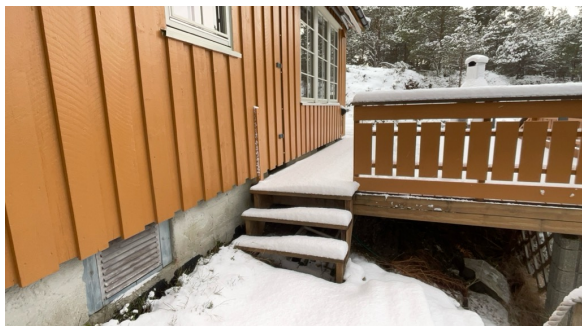
Trapp fra veranda og terrasse mot forsiden av hytten
