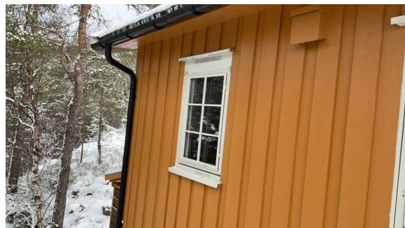
Vindu på soverom
