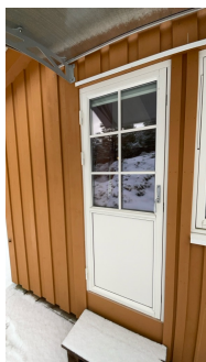
Balkongdør fra 2017 som er montert i 2019.
