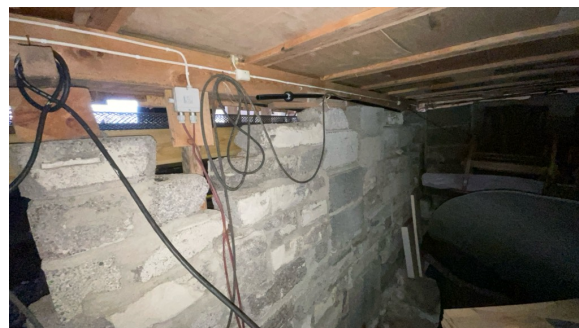
Grunnmur sett fra krypkjeller
