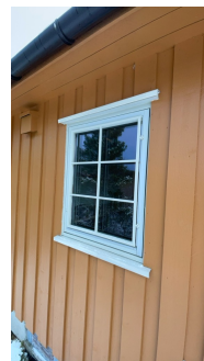
Vindu på kjøkken fra 2007 som er montert 2013
