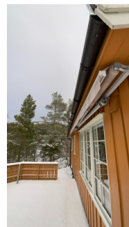
Aluminiums takrenner på forsiden
