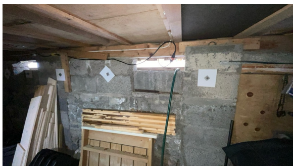
Grunnmur sett fra krypkjeller
