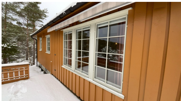
Vindu i stue
