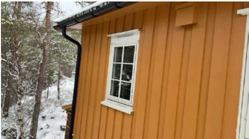
Vindu på soverom
