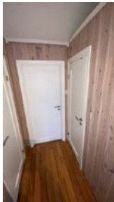
Dør til gang og til bad sett fra kjøkken
