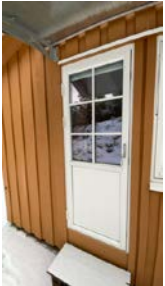
Balkongdør fra 2017 som er montert i 2019.
