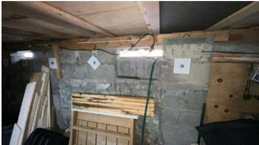
Grunnmur sett fra krypkjeller
