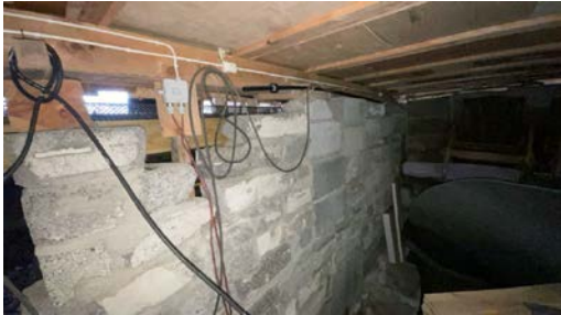
Grunnmur sett fra krypkjeller
