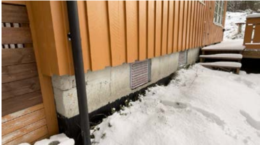
Grunnmur sett fra fremsiden av hytten.
