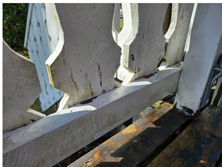
Råteskadet rekkverk.
