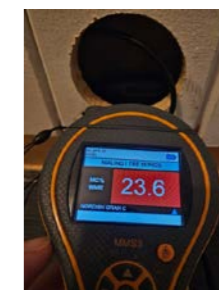
Måling av relativ luftfuktighet i lukket veggkonstruksjon fra gang mot vaskerom.
