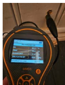
Måling av relativ luftfuktighet i lukket veggkonstruksjon fra gang mot bad.
