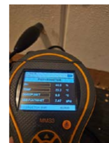
Måling av relativ luftfuktighet i lukket veggkonstruksjon fra gang mot vaskerom.
