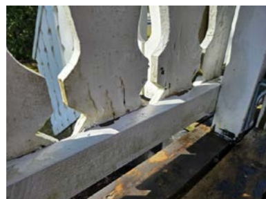
Råteskadet rekkverk.
