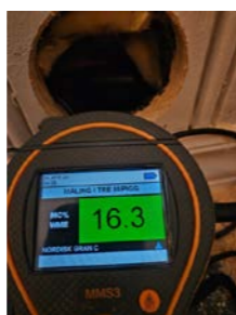
Måling av relativ luftfuktighet i lukket veggkonstruksjon fra gang mot bad.
