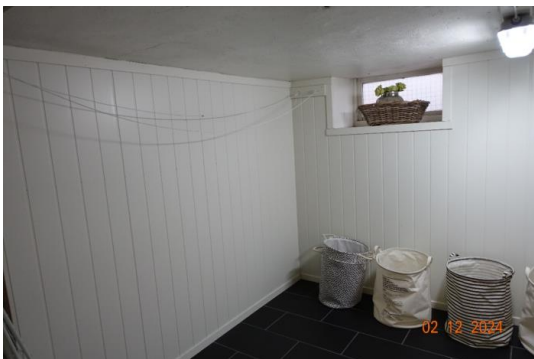
Vaskerom i kjeller.
