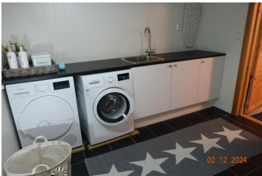
Vaskerom i kjeller.
