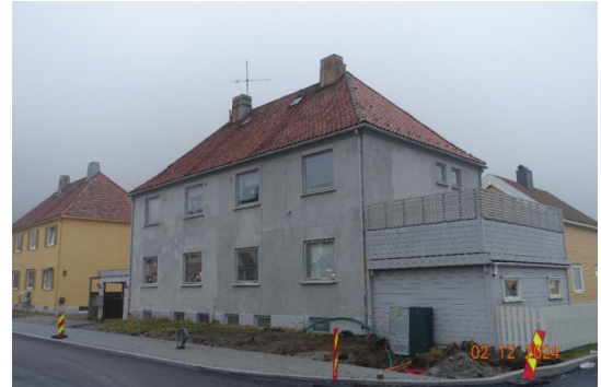
Fasader og tak med tekking
