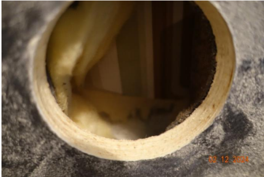
Hulltaking i vegg til bad.
