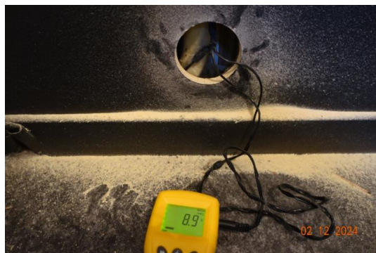
Hulltaking i vegg til bad.
