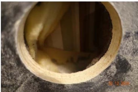
Hulltaking i vegg til bad.
