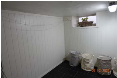
Vaskerom i kjeller.
