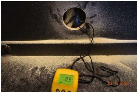
Hulltaking i vegg til bad.
