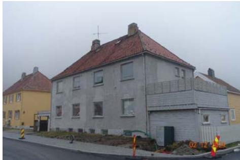
Fasader og tak med tekking
