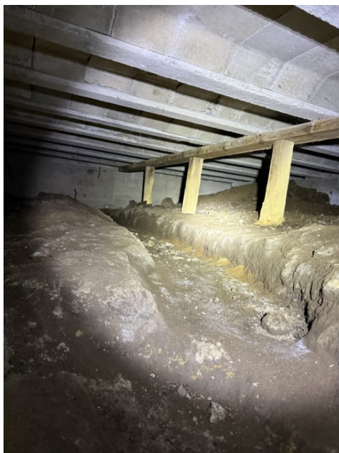
Betongelementer er støttet opp med støtter til bakke.
