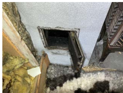
Sotluke med mindre enn 300mm avstand til brennbart materiale
