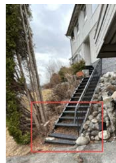
Mangler håndløper på en side.
