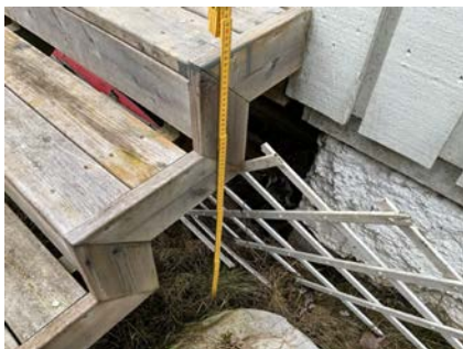
Høyde på mer enn 0,50m fra trinn til terreng.
