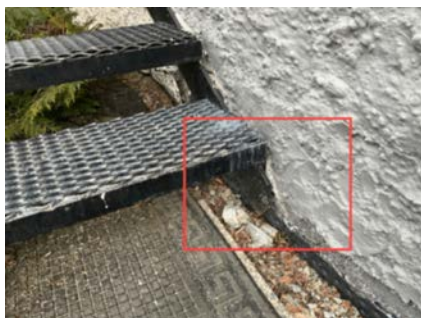
Trappevange mot vegg henger i luften.
