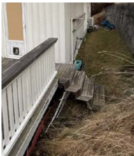
Høyde på mer enn 0,50m fra trinn til terreng.
