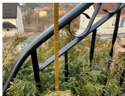
Målt rekkverkshøyde 0,87m
