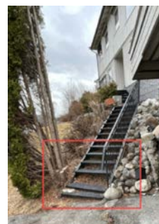
Mangler håndløper på en side.
