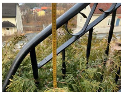
Målt rekkverkshøyde 0,87m
