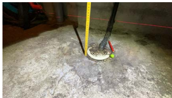
Laserstrek viser 142mm ved sluk.
