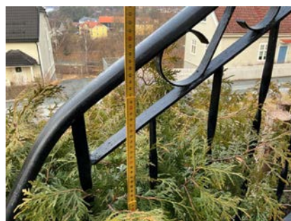
Målt rekkverkshøyde 0,87m
