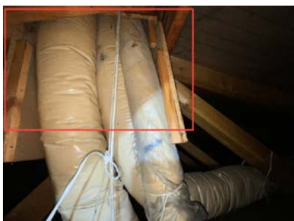
Fuktskjolder på kasse av sponplater til rørgjennomføringer i yttertak.
