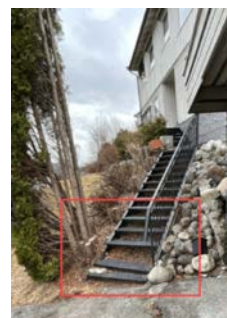
Mangler håndløper på en side.
