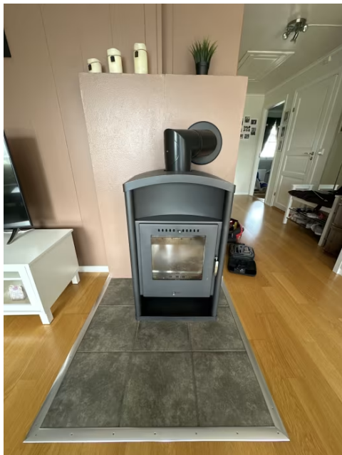
Viser vedovn plassert i stue. Brannsikring på gulv med fliser.
