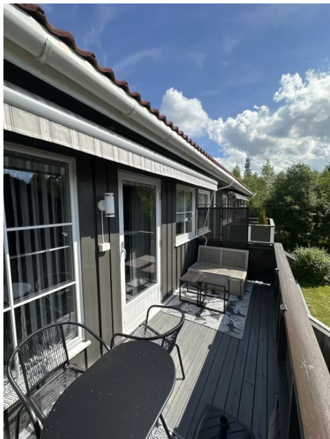
Viser balkong med adkomst fra stue.
