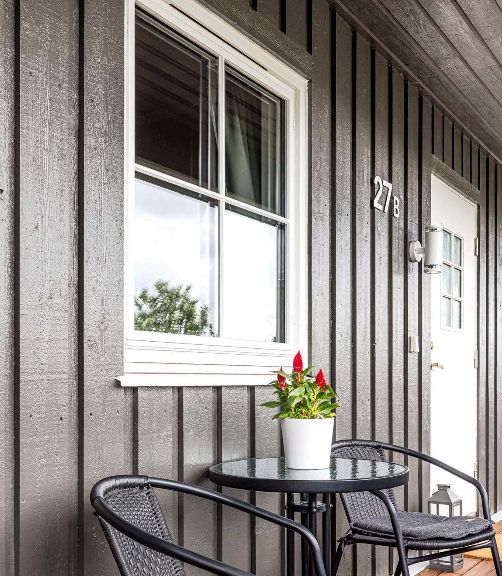
Overbygget svalgang utenfor inngangspartiet.
