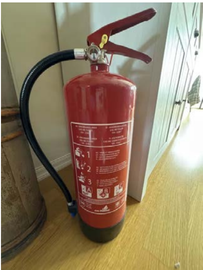
Viser brannslukningsapparat i gang.
