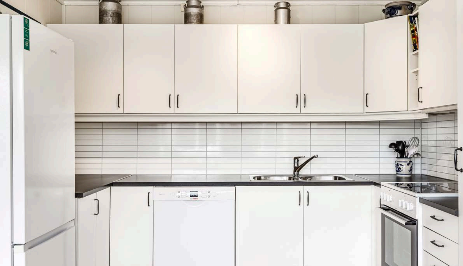
Kjøkkeninnredning hovedsakelig fra byggeår med glatte fronter. Laminat benkeplate med kitchenboards i benkeryggen. Plass til frittstående hvitevarer som kjøl-/fryseskap, komfyr og oppvaskmaskin.
