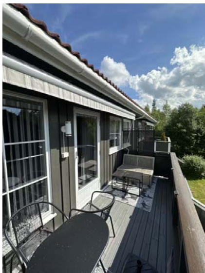
Viser balkong med adkomst fra stue.
