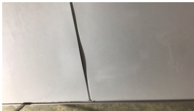
Fukt skader i skjøt
