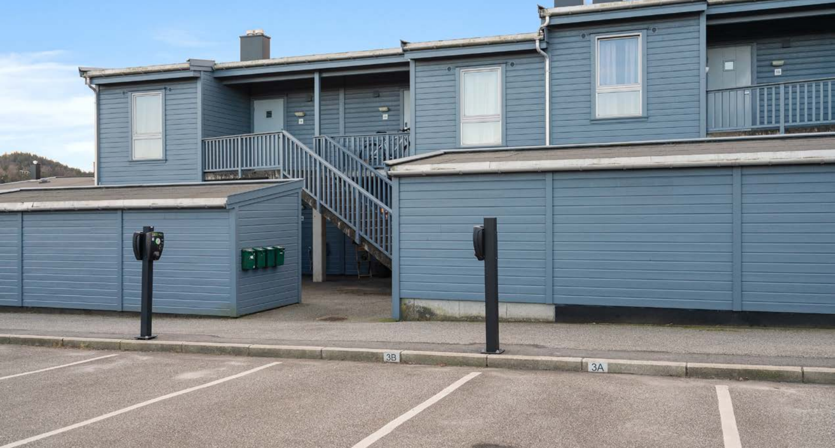
Fast parkering ved inngangsparti. Mulighet for el-lader.
