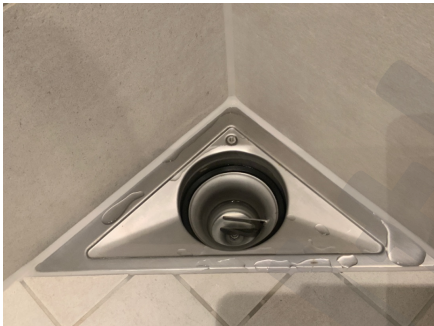
Hovedsluk med klemring for membran
