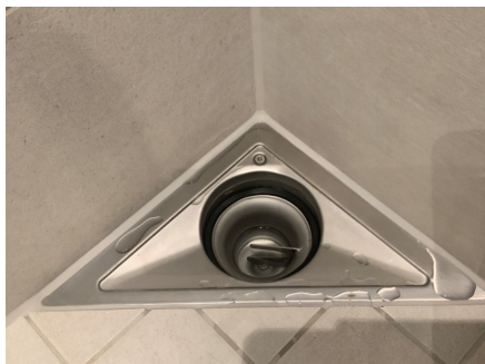
Hovedsluk med klemring for membran
