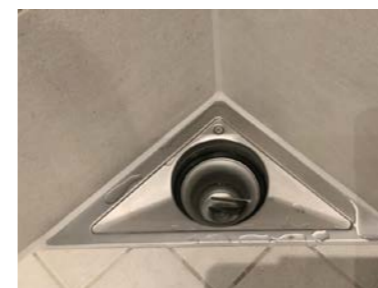
Hovedsluk med klemring for membran
