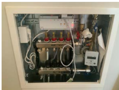
Samleskap for gulvvarme
