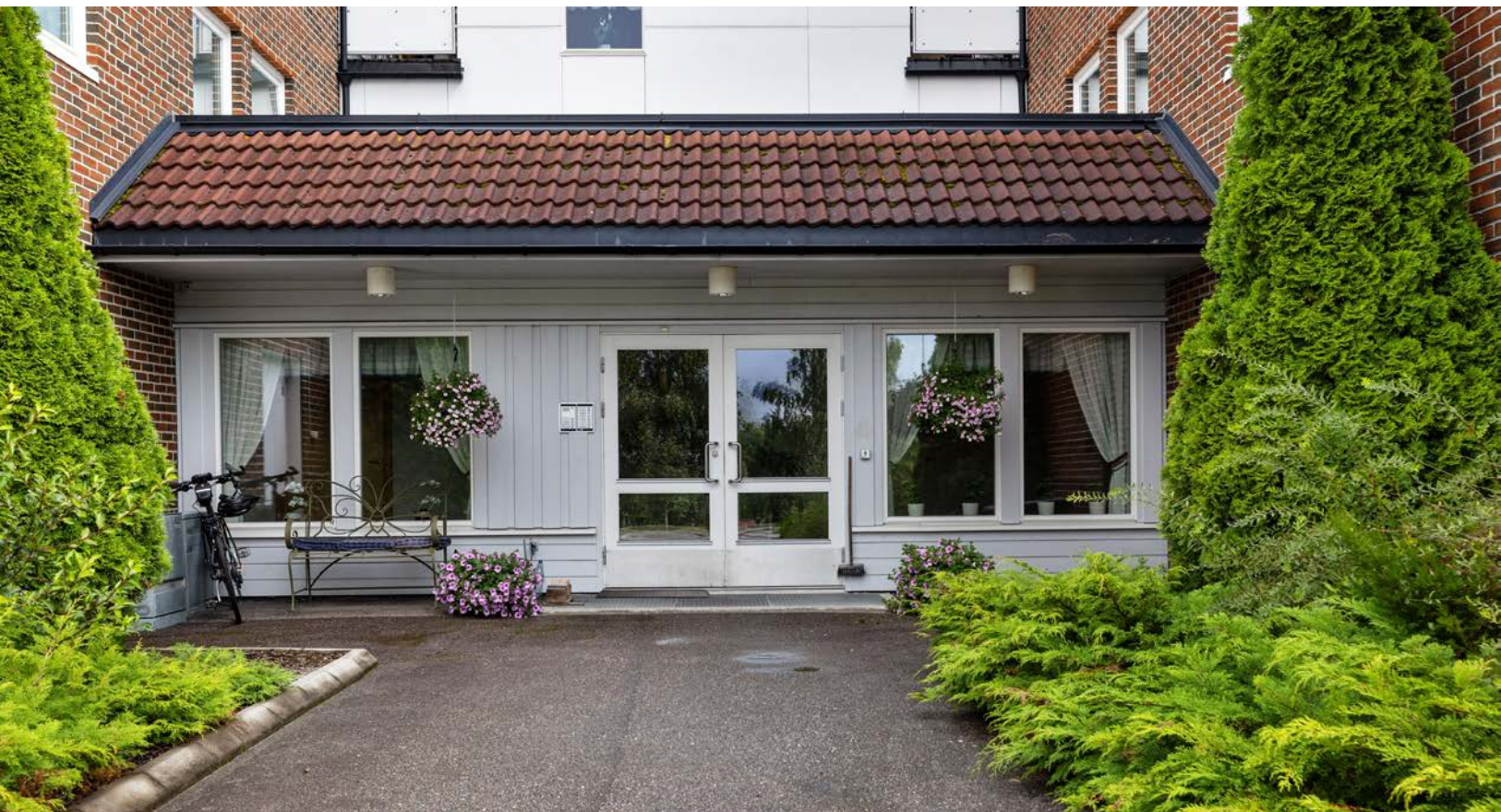
Hyggelig overbygget inngangsparti med belysning og sittebenk. Ved inngangsdøren er det callinganlegg tilkoblet porttelefon i leiligheten.
