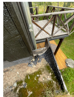
Lokal utbedring av papp/platon.
