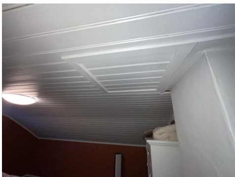
Luke på soverom 1 ved pipe
