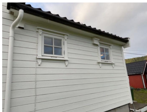
Koblede vindu på toalett og bad
