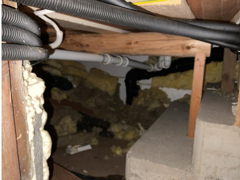
Oversikt krypkjeller sett fra lagerrom
