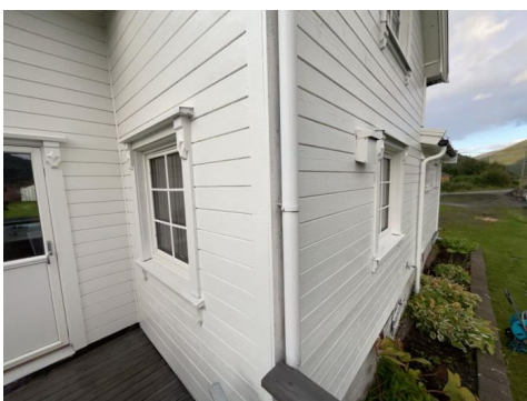
Vindu på kjøkken fra 2008
