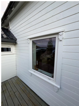
Vindu på spisestue av ukjent alder
