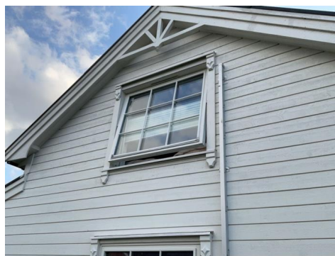
Vindu på soverom
