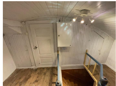
Dør til kott og soverom 3
