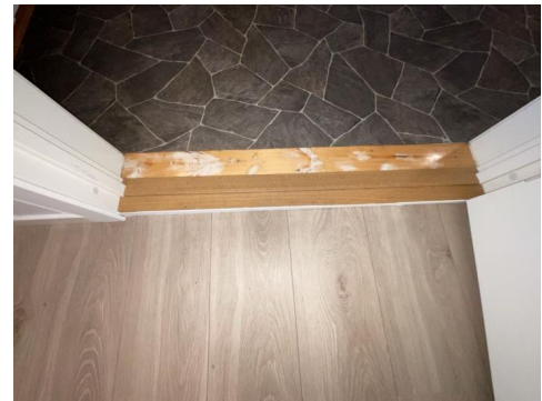
Standard dørterskel mellom kjøkken og toalettrom
