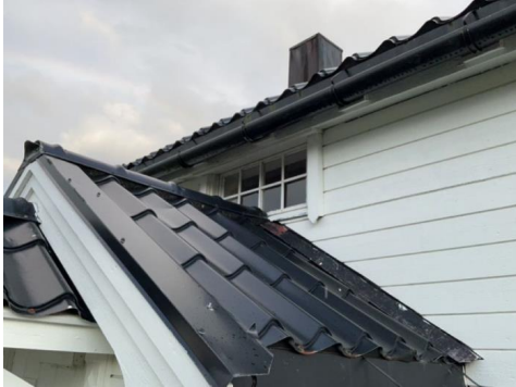
Enkelt vindu på loftsgang
