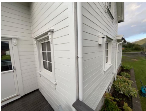
Vindu på kjøkken fra 2008
