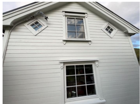
Vindu på soverom og kott
