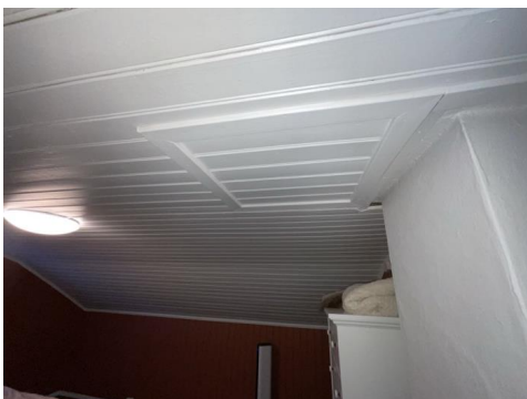
Luke på soverom 1 ved pipe
