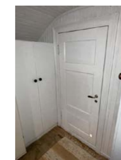
Dør til soverom 2 sett fra gang
