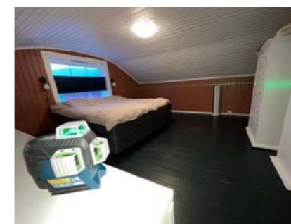
- Plassering av laser ved kontroll av soverom 1. Det er målt 80 mm høydeforskjell gjennom rommet. TG 3. Over en avstand på 2 meter er det målt 55 mm fra hjørne mot gang mot senter av rom. TG 3
