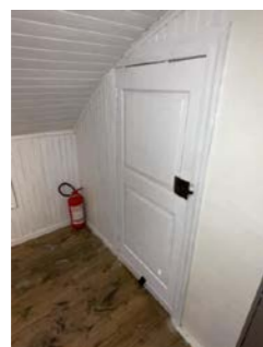
Dør til soverom 1 sett fra gang
