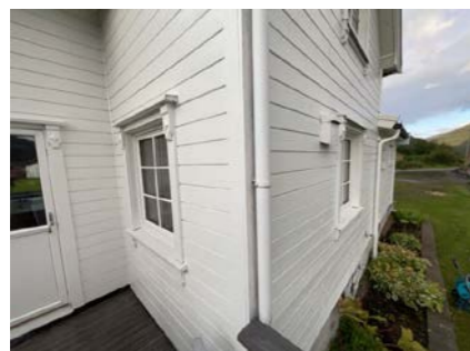
Vindu på kjøkken fra 2008
