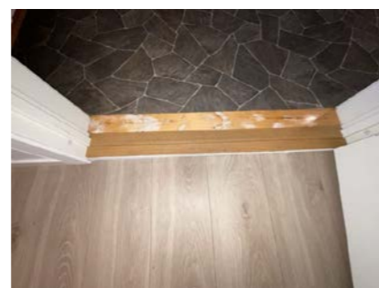
Standard dørterskel mellom kjøkken og toalettrom
