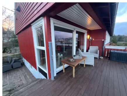
28 mm skjevhet i taket over veranda.
