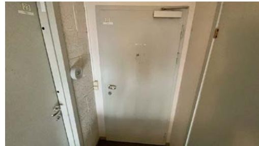
Inngangsdør i stål.
