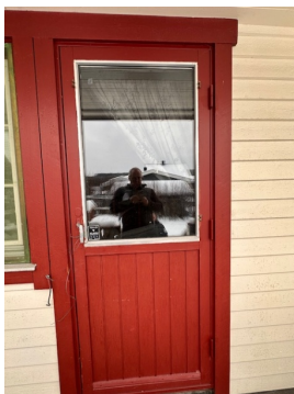
! TG 1 Balkonger, terrasser og rom under balkonger
