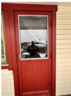
TG 1 Balkonger, terrasser og rom under balkonger
