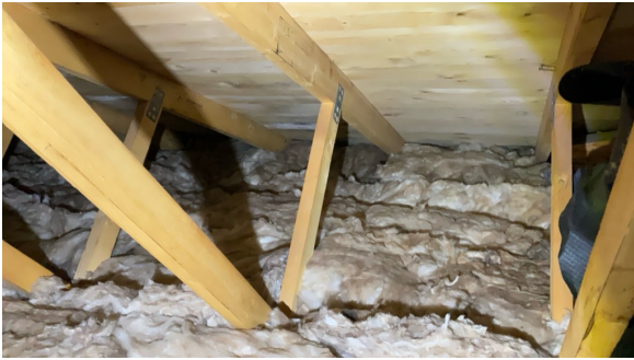
Tilbygg i stue med W-takstoler.
