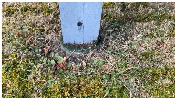
Treverk rett ned på fundamenter.
