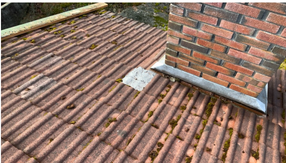
Gamle flate betongtakstein.
