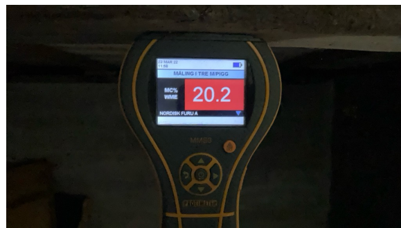
Fuktmåling i bjelker i krypkjeller.
