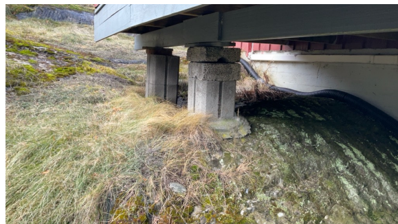
Noen provisoriske fundamenter.
