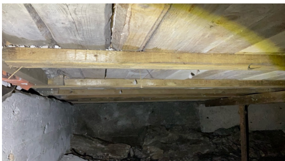
Noe hull etter borebille i bjelkela
