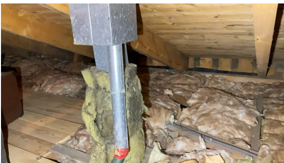
Takgjennomføring for lufting.
