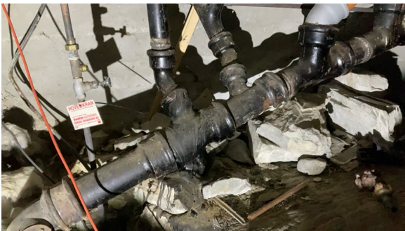
Rør i støpejern i krypkjeller.
