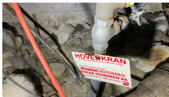
Stoppekran merket i krypkjeller.
