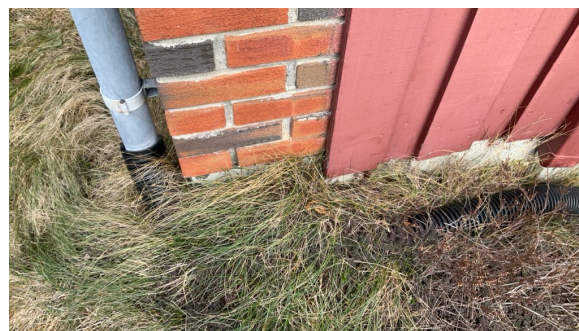
Noe kort avstand fra terreng til underkant kledning.
