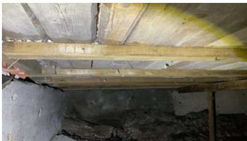
Noe hull etter borebille i bjelkela
