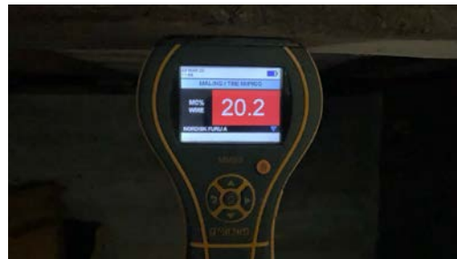
Fuktmåling i bjelker i krypkjeller.
