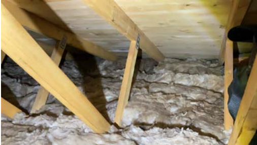
Tilbygg i stue med W-takstoler.
