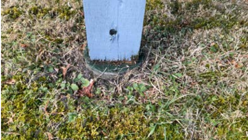
Treverk rett ned på fundamenter.
