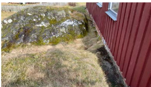
Fall mot grunnmur.
