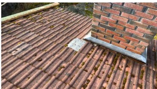
Gamle flate betongtakstein.
