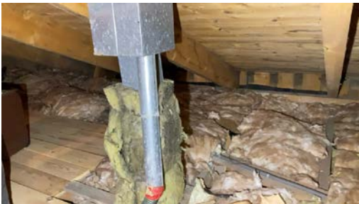
Takgjennomføring for lufting.
