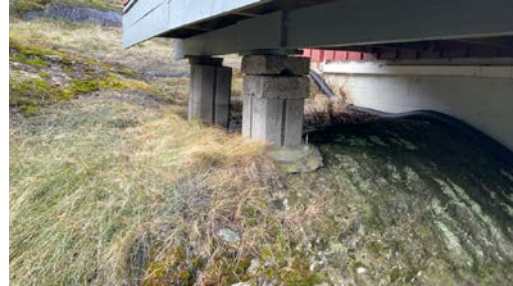
Noen provisoriske fundamenter.
