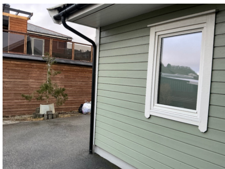
Nedløp er ikke festet med klammer.
