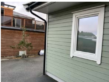
Nedløp er ikke festet med klammer.
