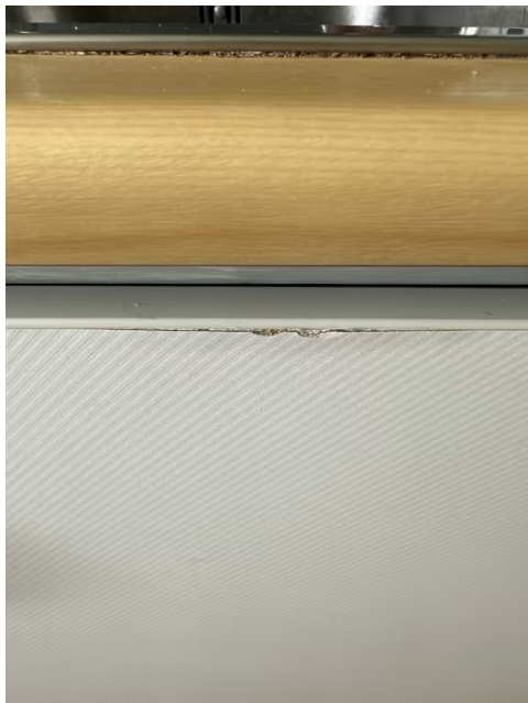
Skapdør utsatt for noe vannsøl. Påvist en liten svelleskade.
