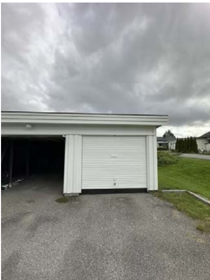
Viser garasjeplass nr 2 fra høyre.
