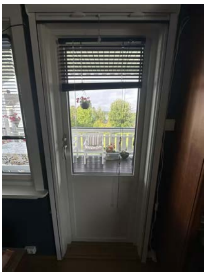
Terrassedør med 3 lags isolerglass fra 2016.
