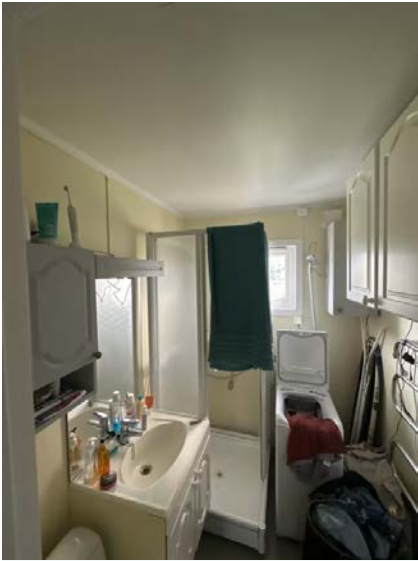
Viser baderomsinnredning, dusjkabinett og opplegg for vaskemaskin.
