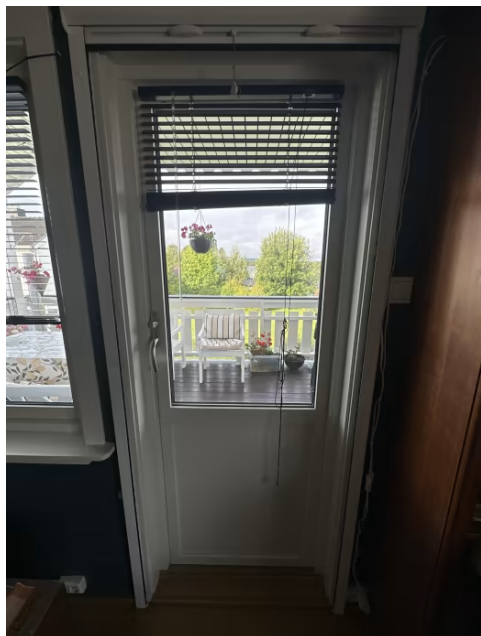
Terrassedør med 3 lags isolerglass fra 2016.
