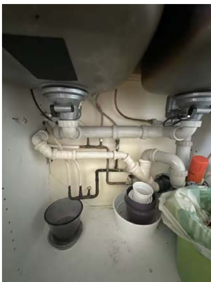
Viser vann og avløpsinstallasjoner under kum.
