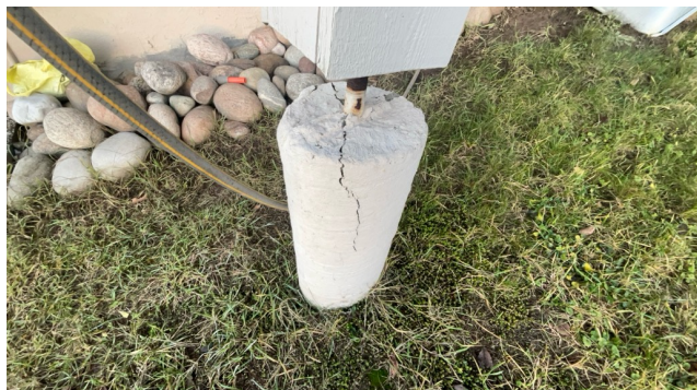
Sprekk pilar
