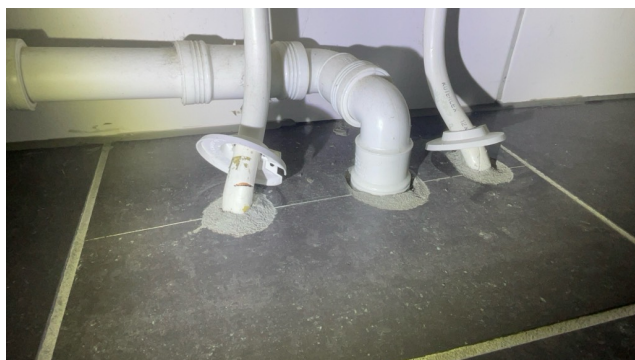
Ikke synlige mansjetter/membran ved rør
