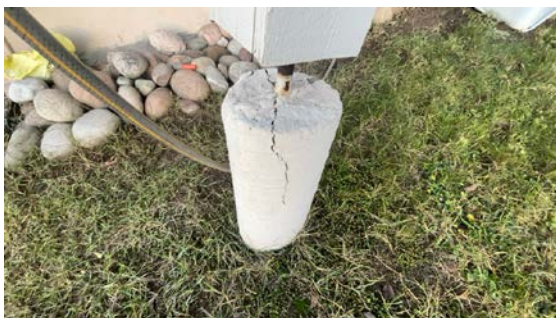
Sprekk pilar
