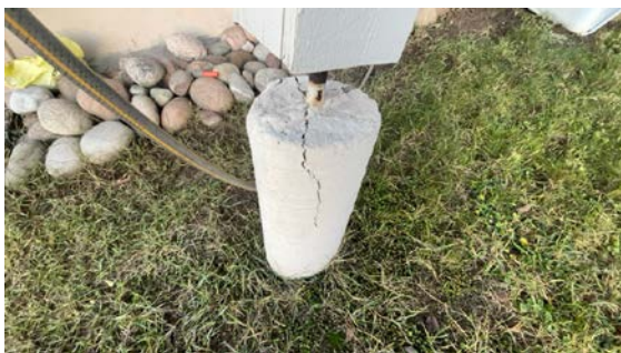
Sprekk pilar
