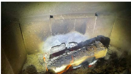
Sprekker ildfast stein
