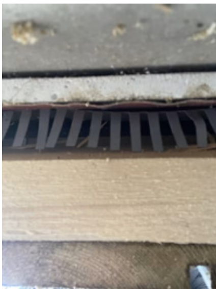
Lufting og musetetting bak kledning.
