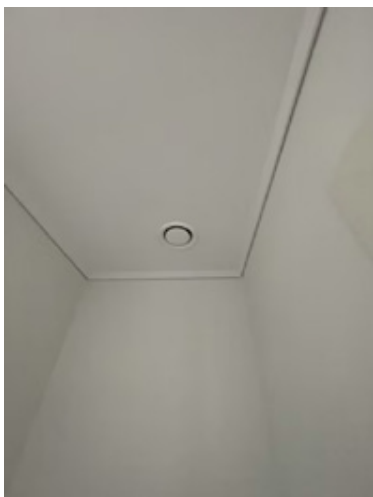
Mekanisk avtrekk i forbindelse med balansert ventilasjon.
