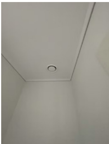
Mekanisk avtrekk i forbindelse med balansert ventilasjon.
