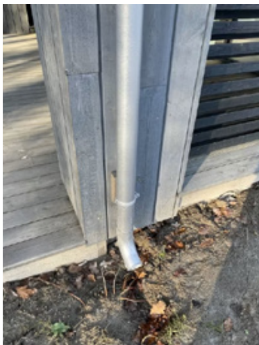
Det er montert utkast på nedløpsrør.
