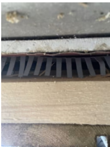
Lufting og musetetting bak kledning.
