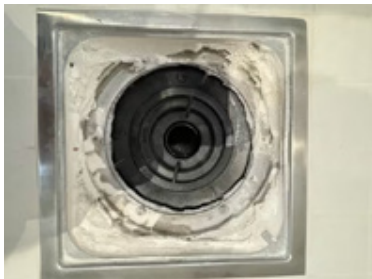
Det er klemt tettesjikt i sluk.
