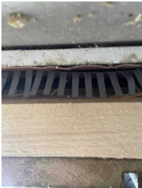
Lufting og musetetting bak kledning.
