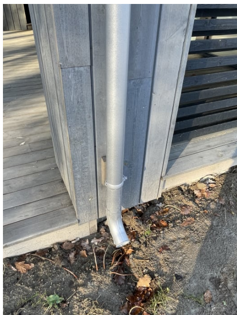
Det er montert utkast på nedløpsrør.
