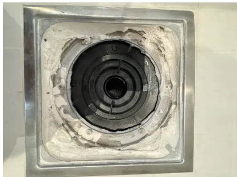
Det er klemt tettesjikt i sluk.
